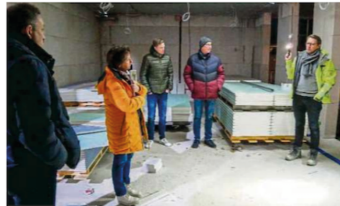
Ingenieur Christoph Sender (r.) berichtete über den aktuellen Stand der Bauarbeiten an der Seniorenresidenz.
