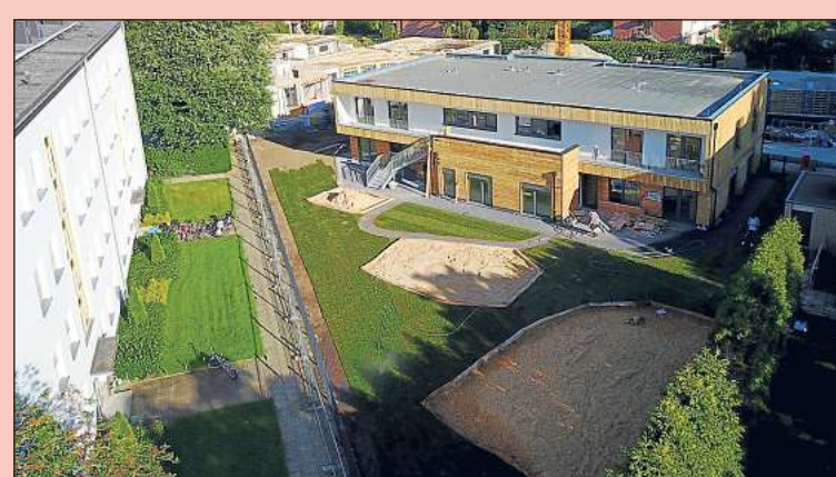
Blick aufs Grüne: Am Donnerstag ist im Außenbereich der Kita Rollrasen verlegt.
