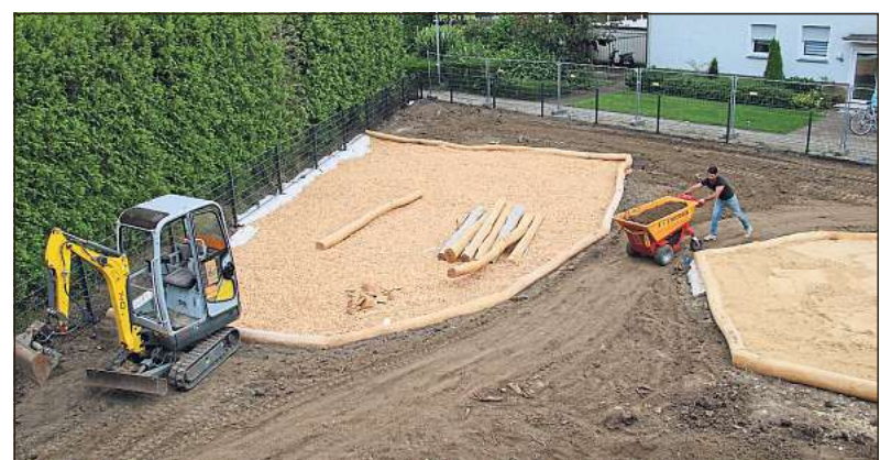
Noch laufen die Arbeiten im Außenbereich der neuen Oelder Kita auf Hochtouren. Am heutigen Donnerstag soll der Rollrasen verlegt werden, Mitte August folgt die Montage der Spielgeräte. Bei der Bepflanzung der Beete dürfen die Kinder mithelfen.
